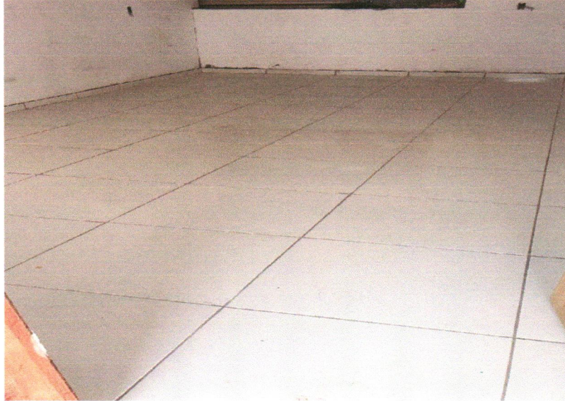
FOTO 151: ASSENTAMENTO PISO CERÂMICO E RODAPÉ
