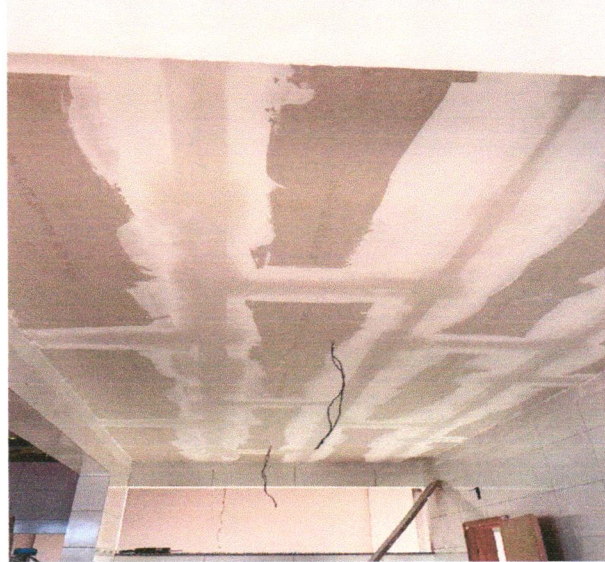
FOTO 153: INSTALAÇÃO FORRO DE GESSO
