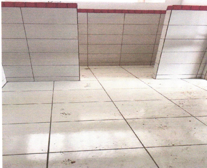
FOTO 150: ASSENTAMENTO PISO CERÂMICO
