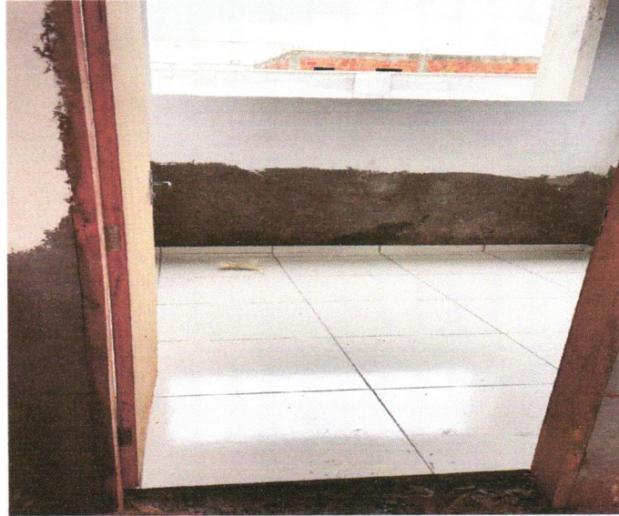
FOTO 149: ASSENTAMENTO PISO CERÂMICO
