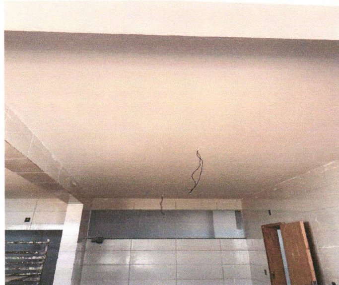
FOTO 154: PINTURA FORRO DE GESSO - EMASSAMENTO
