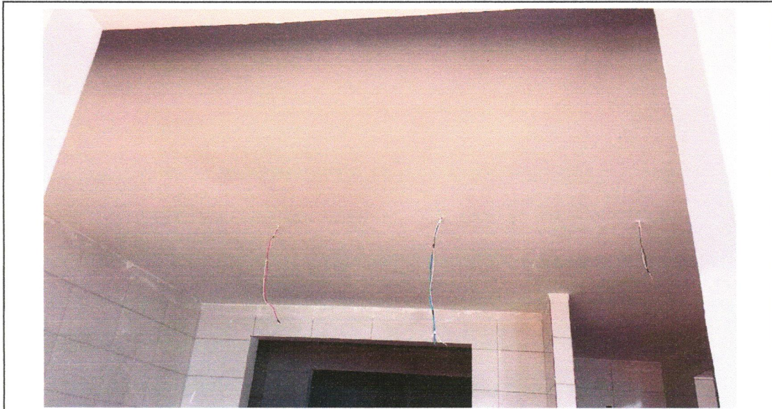
FOTO 155: PINTURA FORRO DE GESSO - EMASSAMENTO
