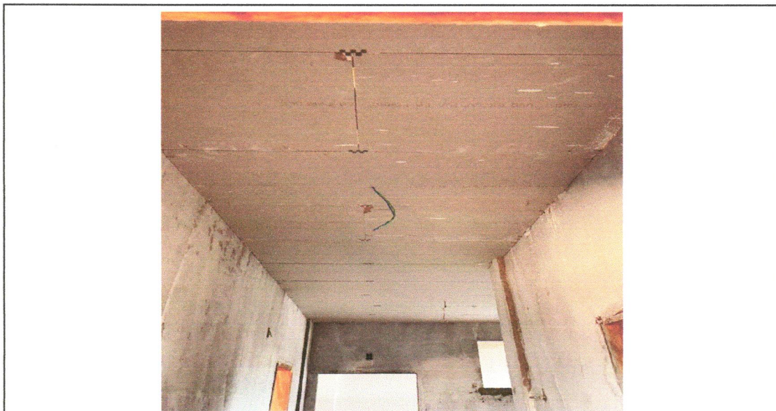
FOTO 156: FORRO DE GESSO
